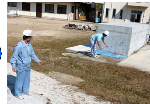
ロッドを反対側から抜いている状況
